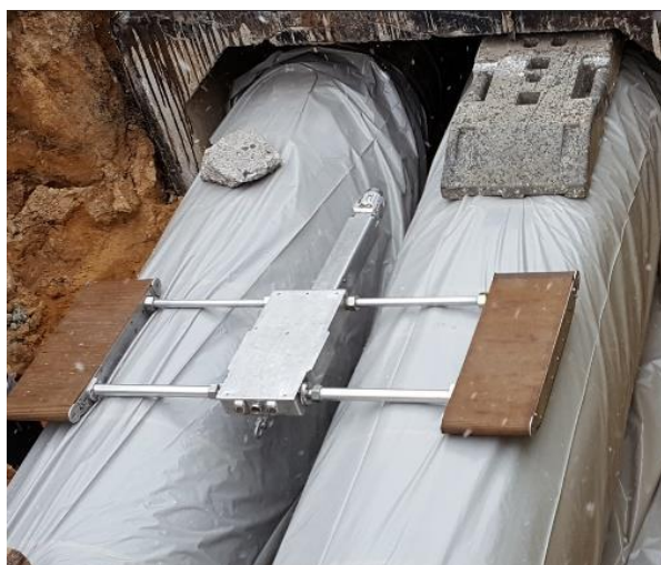
15 paveikslėlis. Vizuali inž. tinklų inspekcija, panaudojant tinklus tiesiogiai žvalgantį įrenginį ("Crawler Eye". Institut für Angewandte Bauforschung Weimar GmbH) (Šaltinis: AGFW)
