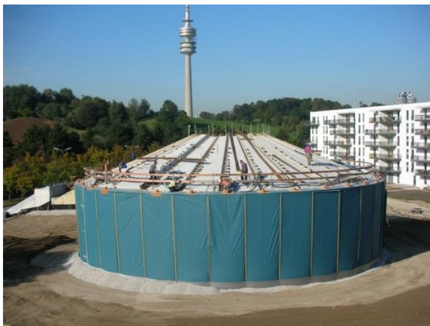
5 paveikslėlis. Šilumos/šalčio kaupykla surinkta iš gamyklinių elementų
