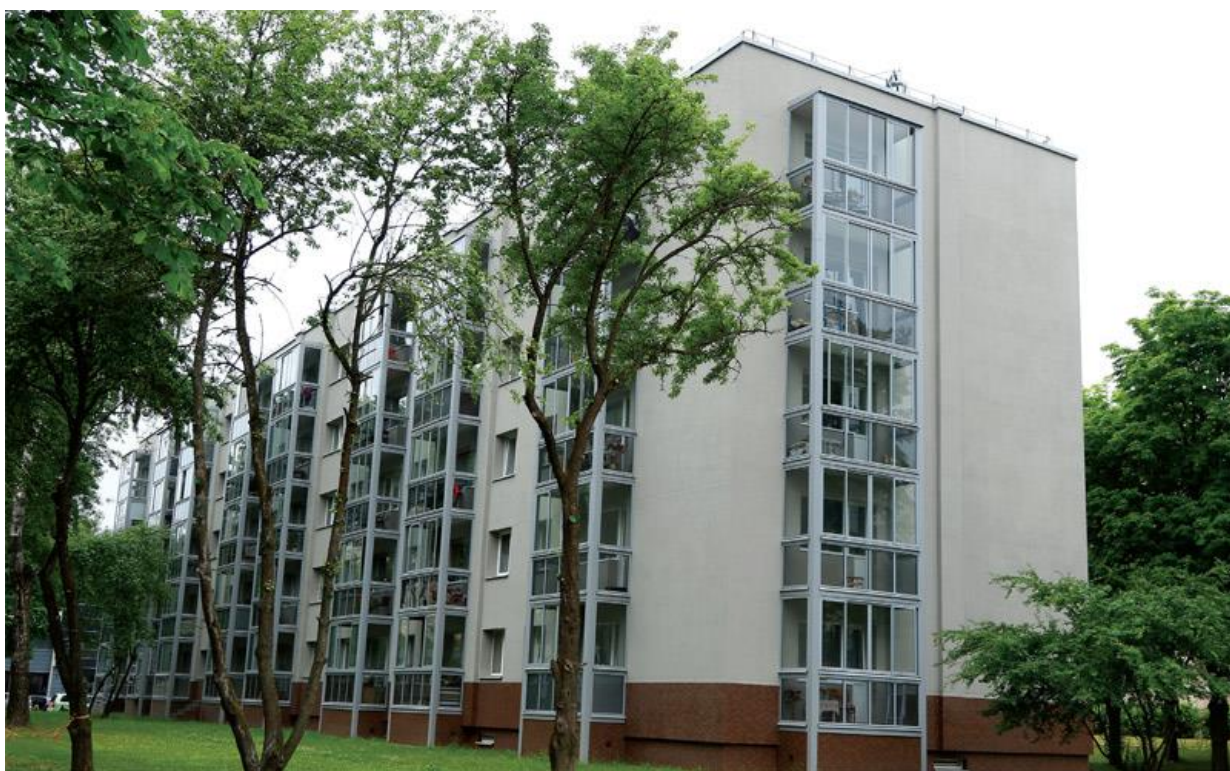
49 paveikslėlis. Daugiabutis namas Žiburio g. 9, Alytuje naudojantis geoterminę energiją
