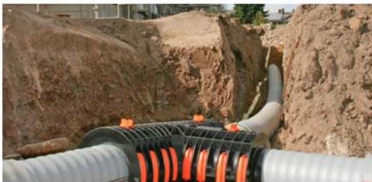
20 paveikslėlis. Žemų temperatūrų tinklai ir suporinti (Twin Pipe) vamzdžiai
